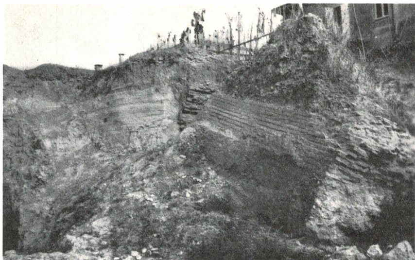
Fig. 3 — Il rudere della cinta del 1518 nel punto di inserzione nel terreno.
