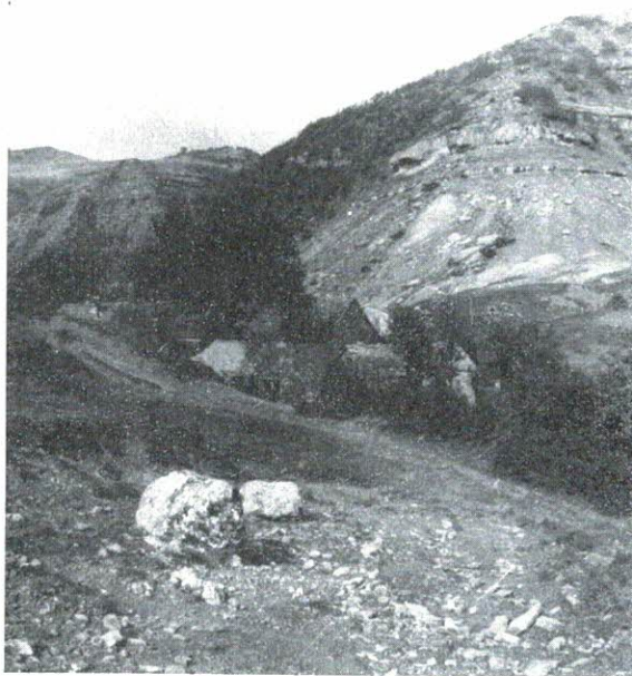
Fig. 3. — Blocchi di calcare a Lucina alla base del grande livello franato che gira intorno al gruppo del M. Faggiola (Prati Piani di Palazzuolo).
