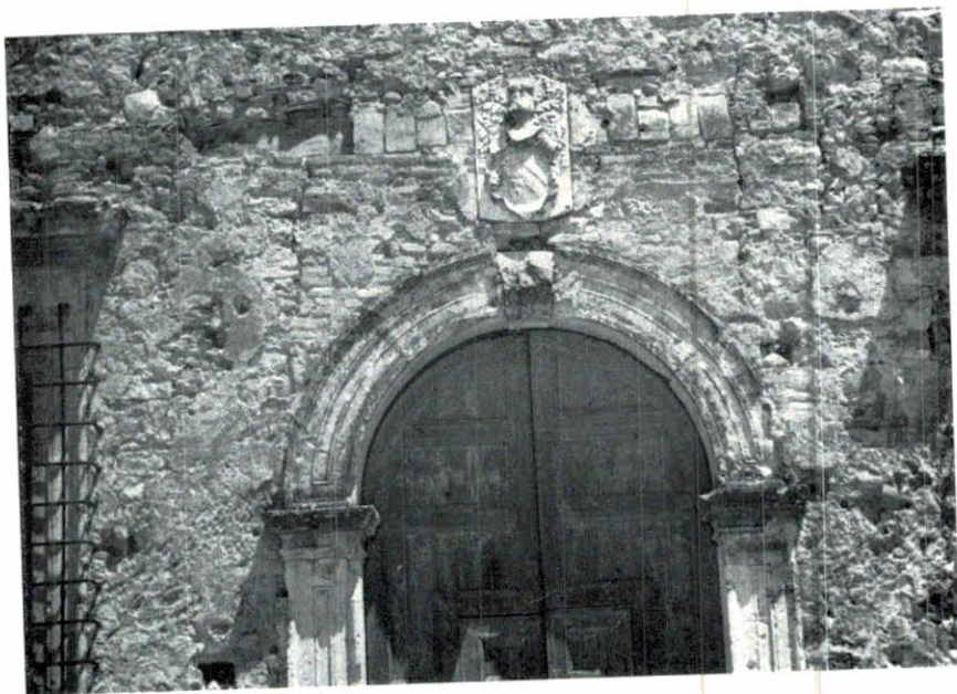
Fig. 11 — MONTECODRUZZO, Chiesa di S. Maria Liberatrice - Portale d'ingresso in pietra calcarea locale (Foto Pedrelli, 1953).
