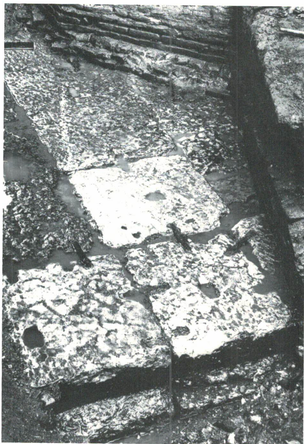
Fig. 5. SAVIGNANO SUL RUBICONE, conci della platea di fondazione del ponte romano.
