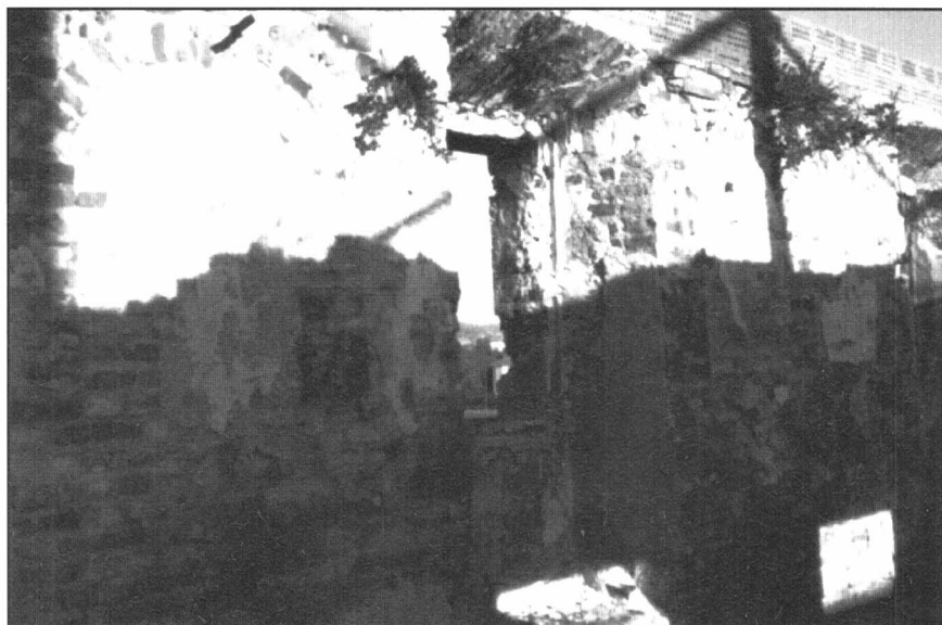
Fig. 7. Tratto di muro perimetrale con tracce di archetti e beccatelli sul lato interno dell'edificio
