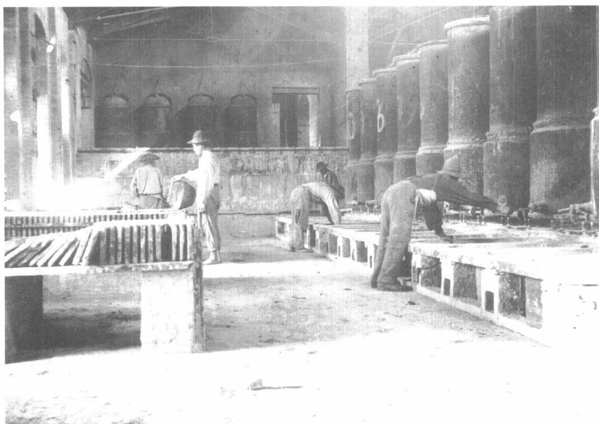
Fig. 8. FORMIGNANO DI BORELLO (Fo). Capannone adibito alla lavorazione dei pani di zolfo (foto Gaetano Brasa)
