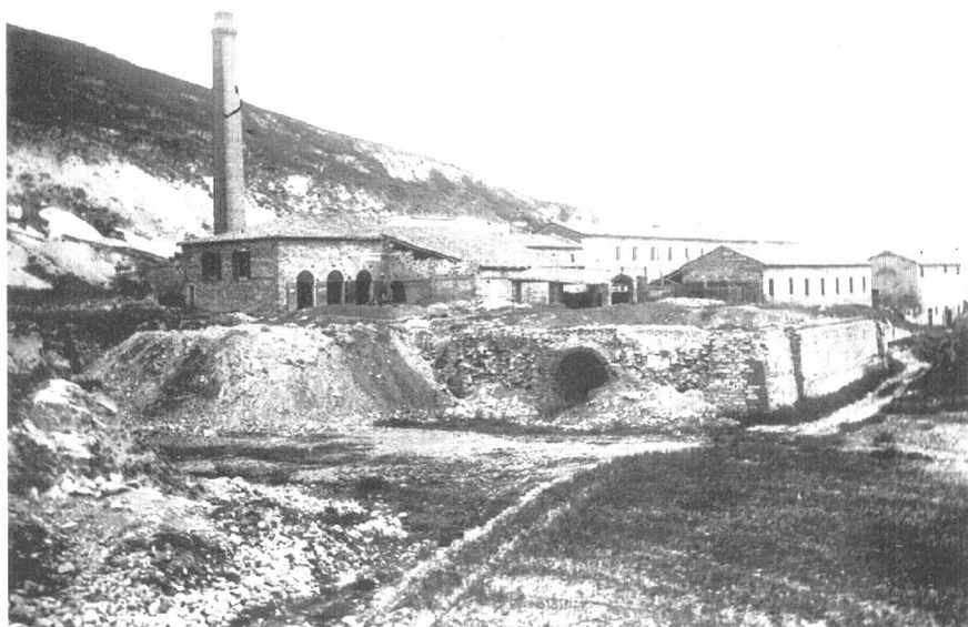
Fig. 5. FORMIGNANO DI BORELLO (Fo). Fabbricati, ciminere, abitazioni e uffici della miniera (foto Gaetano Brasa)
